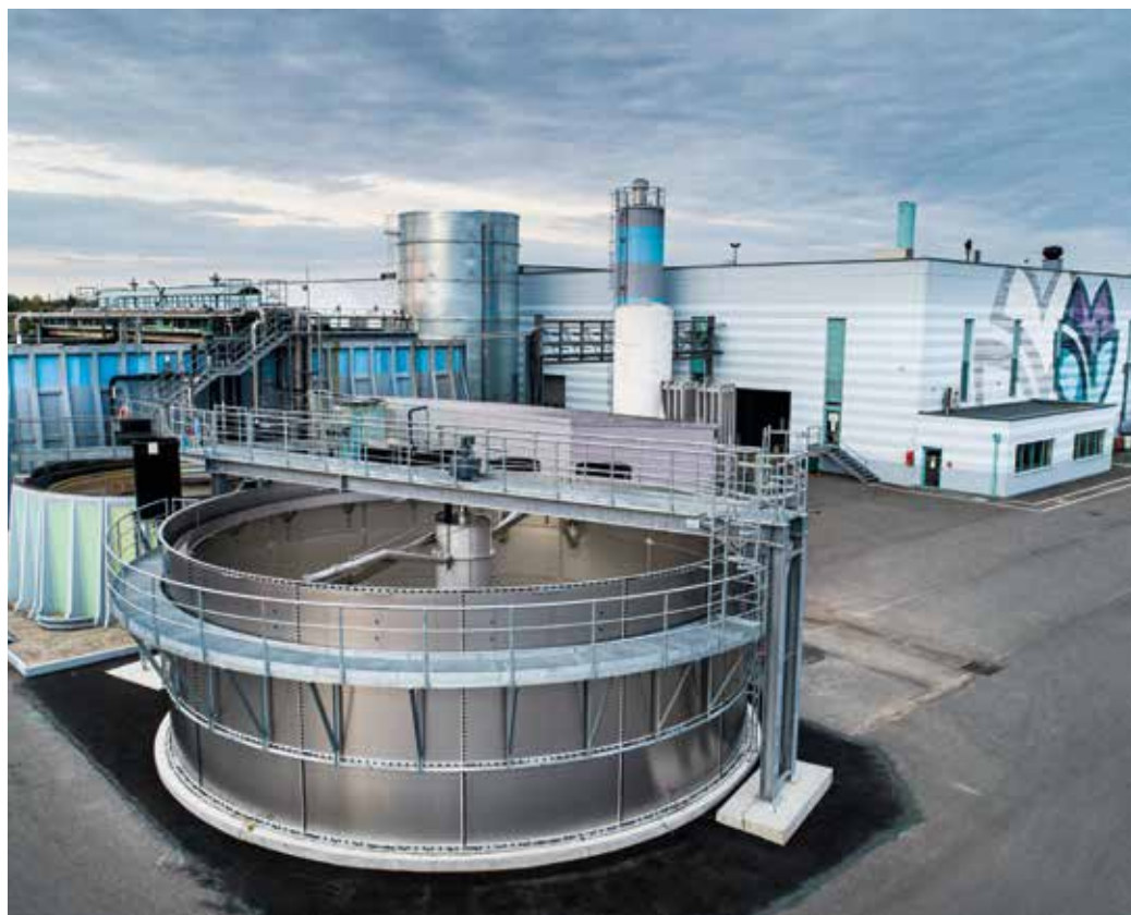
Abwasseraufbereitungsanlage Mewa (Foto: Mewa)
